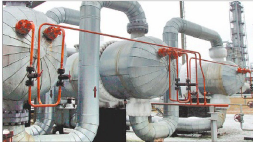
Wenn im Fruhjahr die Genehmigung des Landesbergbauamtes Clausthal-Zellerfeld vorliegt, konnte E.on noch vor dem Sommer mit der Realisierung fur die Gasspeicheranlage ostlich des IVG-Stammgelandes beginnen.
