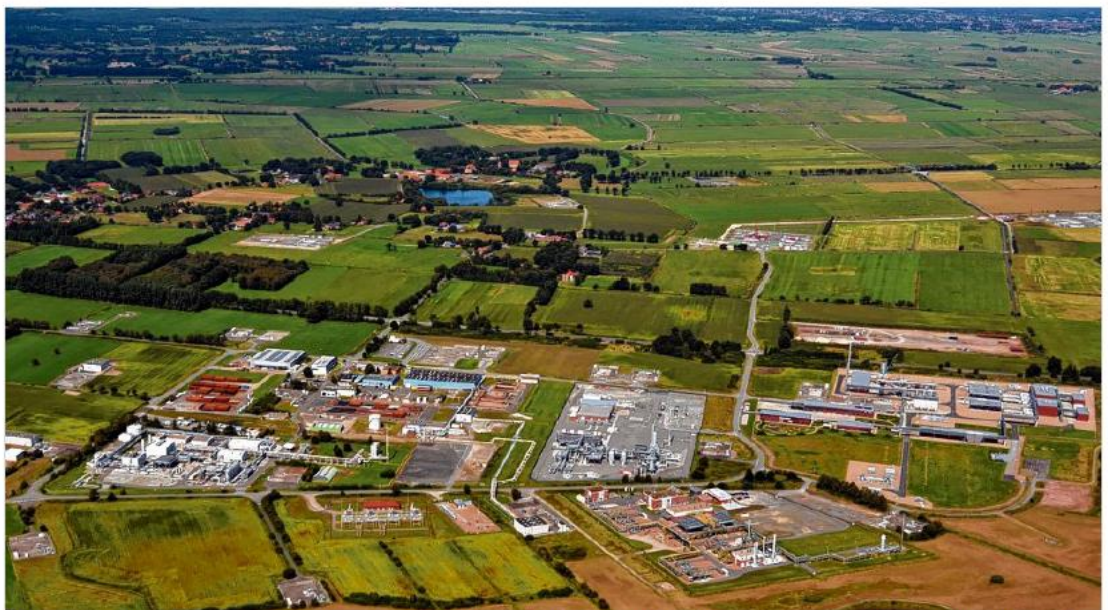
Das Kavernenfeld bei Etzel aus der Vogelperspektive: Der Boden dort ist wegen der zahlreichen Hohlräume unter Tage bereits abgesunken und wird das auch weiterhin tun. Die Anwohner betrachten das mit Sorge. BILD: STORAG ETZEL
